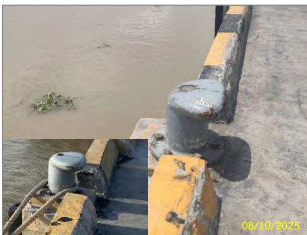
ติดตั้งหลักผูกเรือ และยางกันกระแทกเรือบริเวณท่าเรือ
